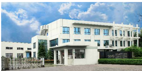
上海奉贤庄行欧洲工业园区的上海信基工业园 Shanghai Singi Electrical Co. Ltd
