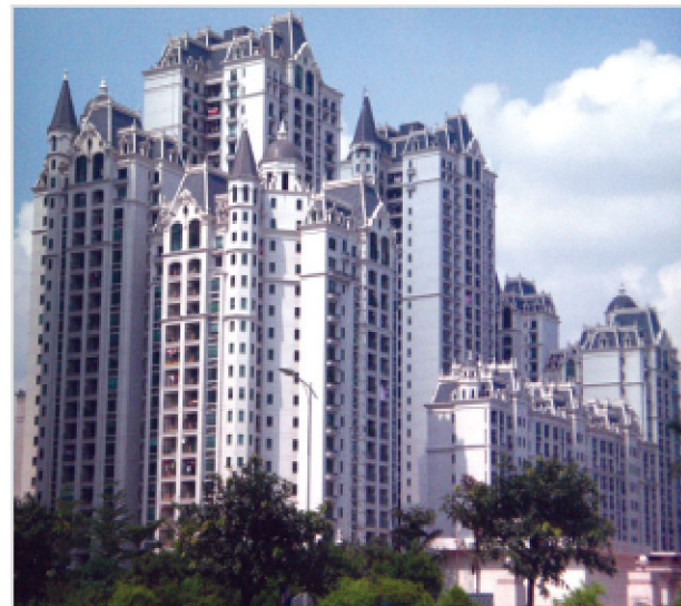
工程名称：广东豪门大厦 Project Name : Guangdong Royal Family Mansion
