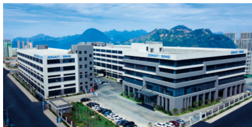
浙江信基电气股份有限公司工业园 Zhejiang Singi Electrical LLC
